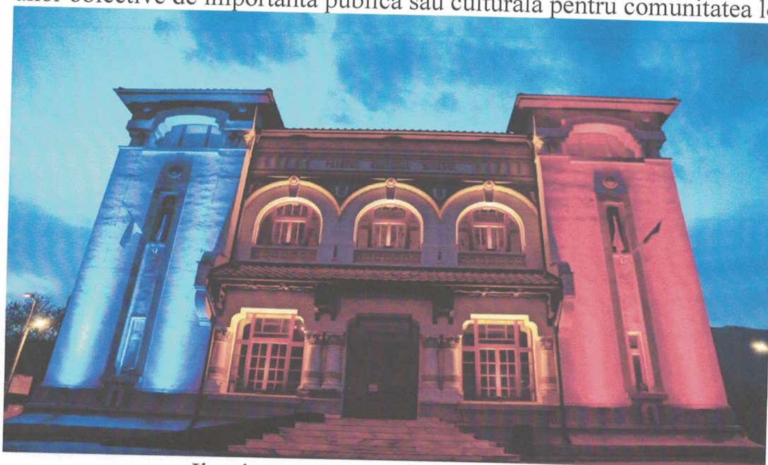
Iluminat arhitectural Palat cultură
